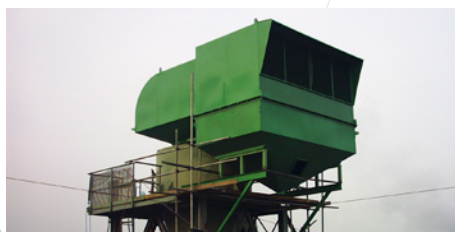
Alcoa Köfém – forgácselszívó ciklon zajcsökkentése
