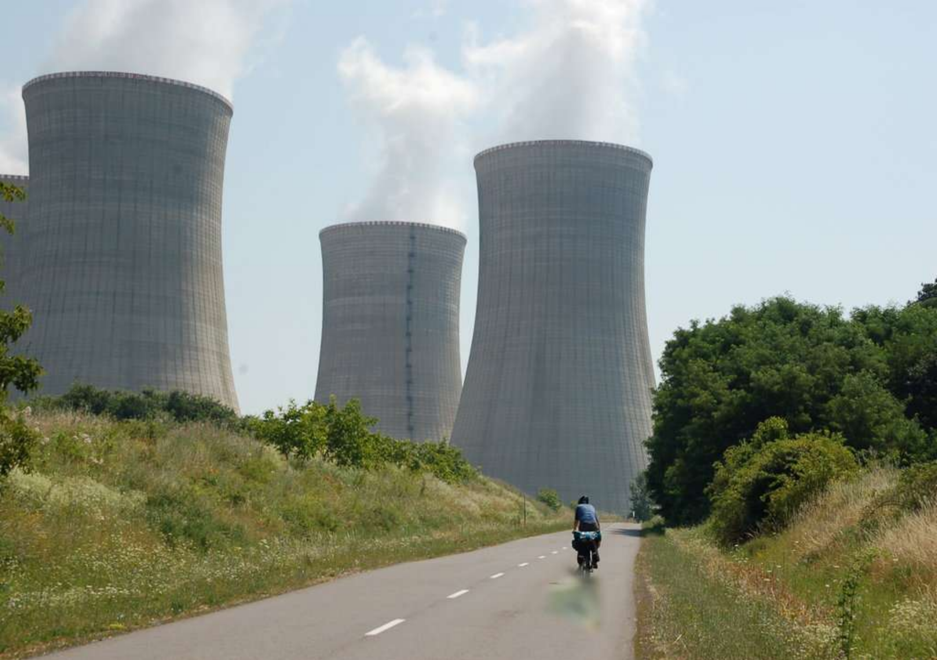
A Mohi Atomerőmű hűtőtornyai
